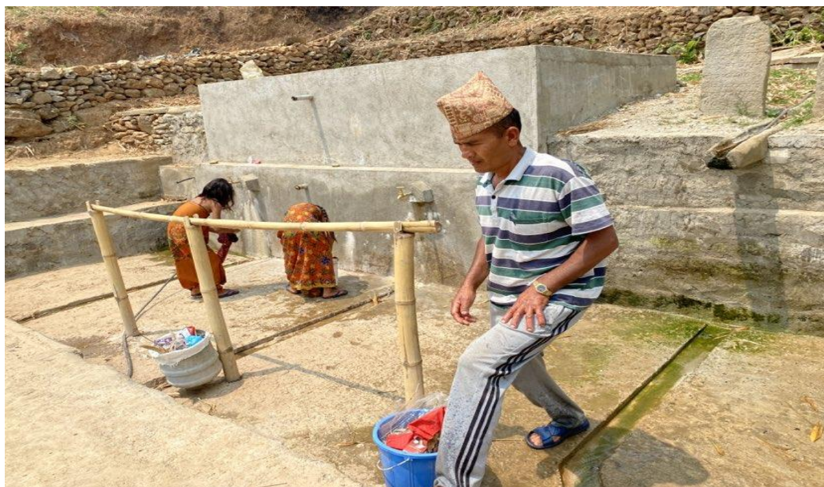
ठाडो धारा र चिउरीधारा पानी ट्याङ्की निर्माण
