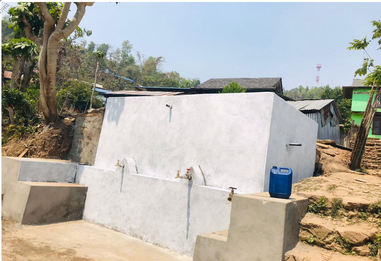
कोटथोक खानेपानी ट्याङ्की निर्माण
