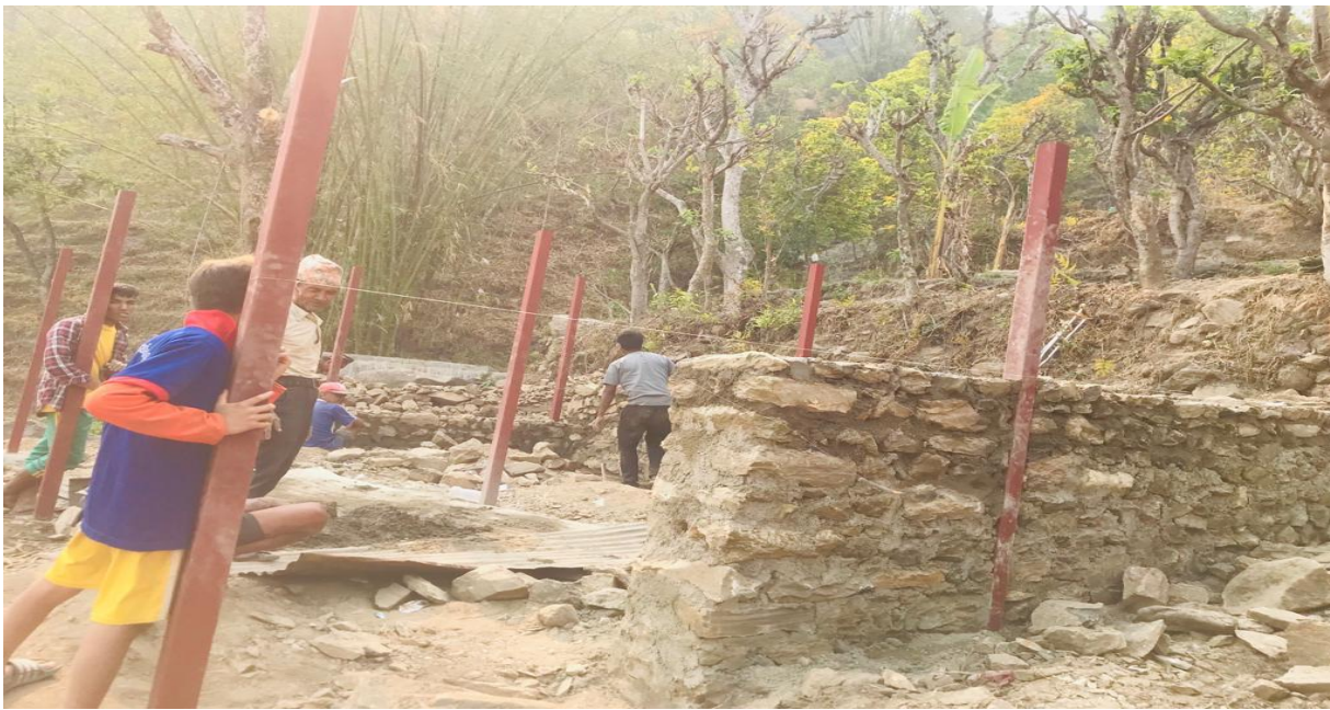
खगि आरान भवन निर्माण
