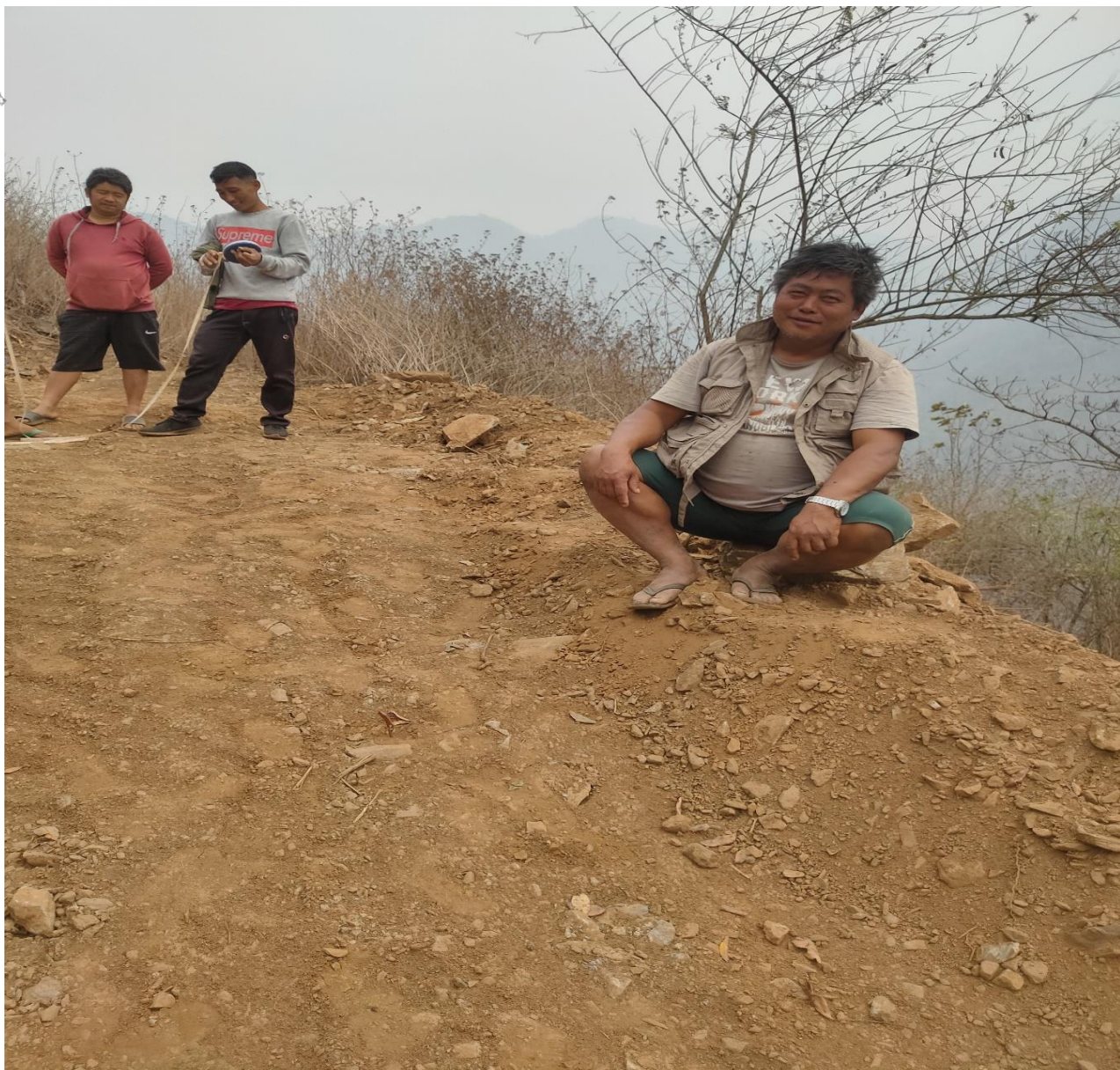
नयाँवस्ती देखि निभारे मोटर बाटो निर्माण
