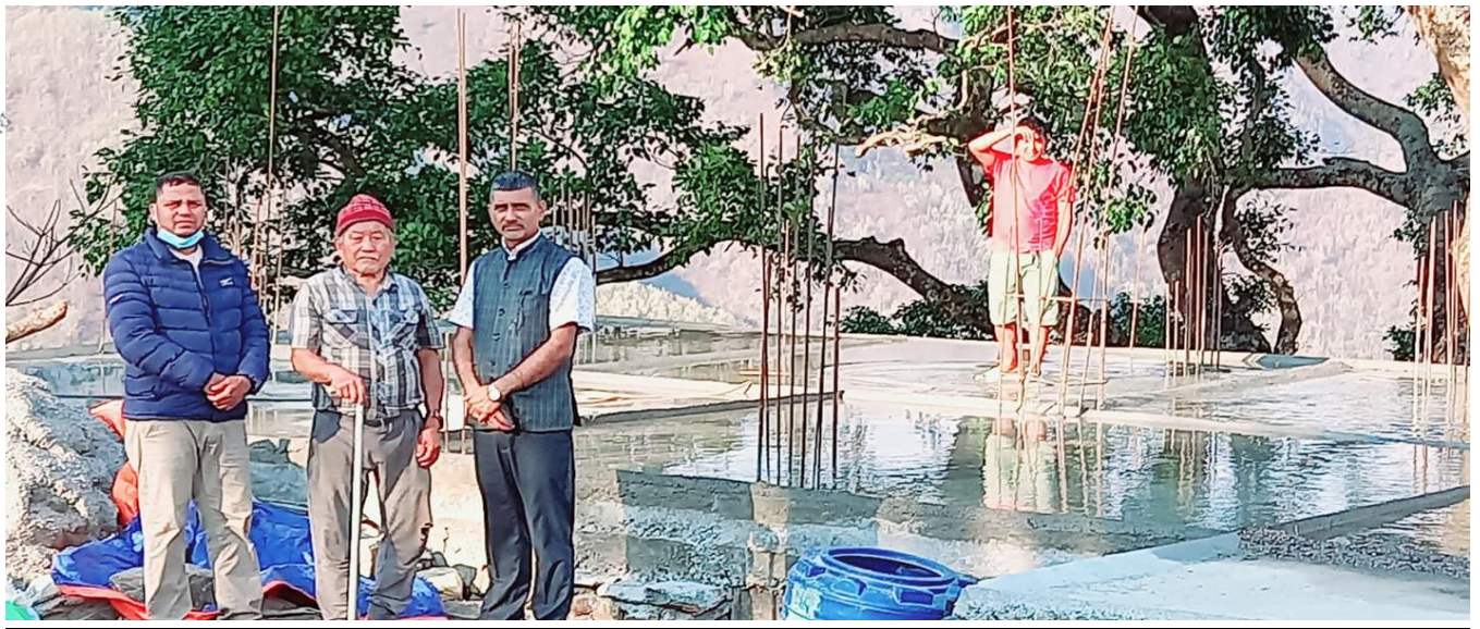
तल्लो ग्याङ्गा बौद्धनाथ गुम्बा निर्माण
