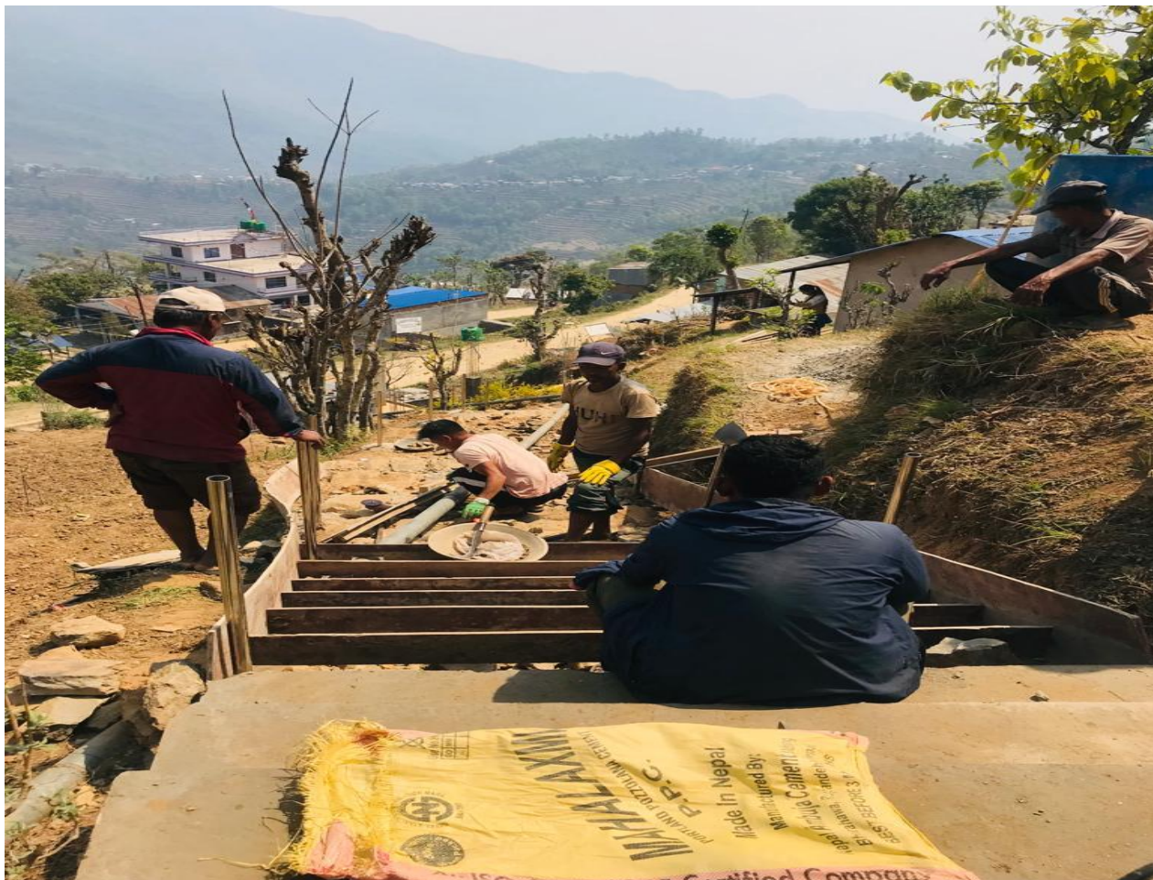
पिपलछाप वस्ती भित्रको सिँडिबाटो निर्माण
